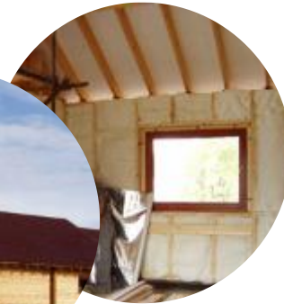
Vivienda unifamiliar (República Checa)
